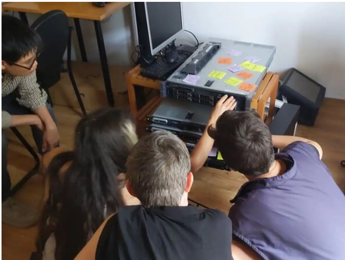
Parcours des serveurs rack donnés pour en choisir un à reformater et à installer avec le système d'exploitation Linux et PeerTube, lors du premier jour de notre session de travail d'une semaine à Ca la Dona.
